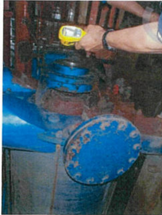
ตรวจเช็คและจุดบันทึกระดับน้ำบนแก๊ส และอุณหภูมิของแก๊ส
