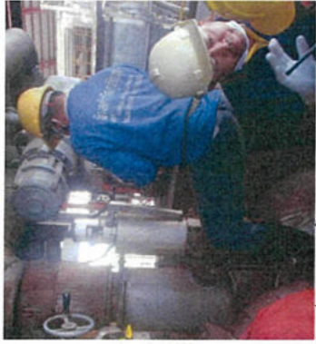
ขั้นตอนที่ 8 เมื่อทำการปรับตั้ง Safety valve Superheat แล้วเสร็จ ทำการปรับตั้ง Safety valve Upper Drum ขั้นตอนที่ 9 ช่างหม้อไอน้ำทำการคลายน็อตยึดตัว Safety valve ที่ Upper Drum ด้านซ้ายออก
