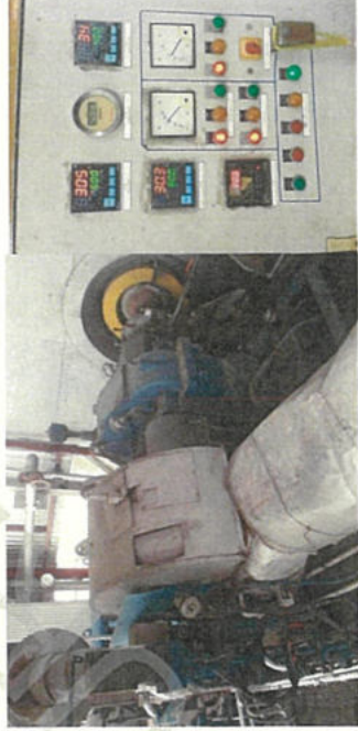
ขั้นตอนที่ 16 ลดวาล์วระบบซูเปอร์ฮีทลง IDF
