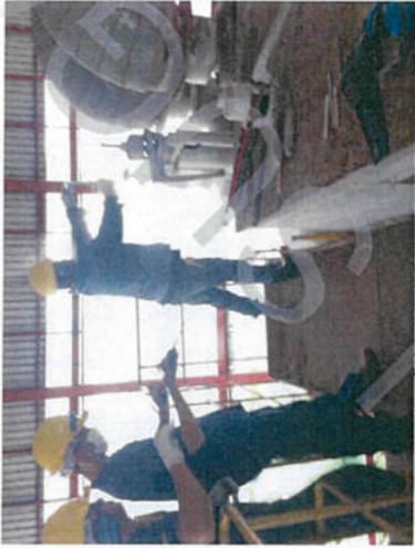
ขั้นตอนที่ 13 ทดสอบ ทำแรงดันไอน้ำขึ้นไปที่ 46.5 – 47.5 kg/cm 2 อีกครั้ง ดูว่าเทฟต้าจะเปิดที่ 46.5 – 47.5 kg/cm 2 หรือไม่ ถ้าไม่เปิด ทำการปรับตั้งแบบเดิมอีกครั้ง ขั้นตอนที่ 14 เมื่อทำการปรับตั้ง Safety valve Upper Drum ด้านซ้ายแล้วเสร็จ ทำการปรับตั้ง Safety valve Upper Drum ด้านขวา ขั้นตอนที่ 15 ช่างหม้อไอน้ำทำการคลายน็อตยึดตัว Safety valve ที่ Upper Drum ด้านขวาออก ขั้นตอนที่ 16 ช่างหม้อไอน้ำทำการขันล็อกน็อตยึดตัว Safety valve superheat และ Upper Drum ด้านซ้าย ขั้นตอนที่ 17 ช่างหม้อไอน้ำทำการใส่โอเปกออก โดยการโยกคันโยกประมาณ 2 – 3 ครั้ง ๆ ละ 30 วินาที – 1 นาที จนโอเปกออกหมด ขั้นตอนที่ 18 เมื่อโอเปกออกไล่จนหมดแล้ว พ่นงานควบคุมหม้อไอน้ำ ทำแรงดันไอน้ำขึ้นมาจากวาล์ว ปล่อยไอน้ำเปิด กรณีที่เทฟต้ายังไม่เปิดเมื่อแรงดันถึง 47.5 kg/cm 2 ทำการเปิด Start วาล์ว ปล่อยไอน้ำ – กรณีที่เทฟต้าจะเปิดที่แรงดันไอน้ำไม่ถึง 46.5 kg/cm 2 ช่างหม้อไอน้ำทำการขันน็อตยึดสลึงเพื่อใส่สลึงเสริมจนกว่าเทฟต้าจะเปิดที่แรงดันไอน้ำ 46.5 – 47.5 kg/cm 2 จากนั้นทำการขันล็อกน็อตสลึง – กรณีแรงดันไอน้ำขึ้นมาเกิน 47.5 kg/cm 2 แล้วเทฟต้ายังไม่เปิด พ่นงานช่างทำการคลายน็อตยึดสลึงเพื่อใส่สลึงเสริมจนกว่าเทฟต้าจะเปิดที่แรงดันไอน้ำ 47 – 47.5 kg/cm 2 จากนั้นทำการล็อกน็อตสลึง
