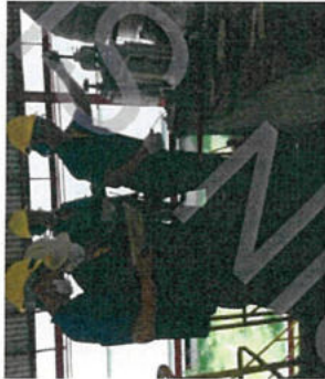
ขั้นตอนที่ 8 เมื่อทำการปรับตั้ง Safety valve Superheat แล้วเสร็จ ทำการปรับตั้ง Safety valve Upper Drum ขั้นตอนที่ 9 ช่างหม้อไอน้ำทำการคลายน็อตยึดตัว Safety valve ที่ Upper Drum ด้านซ้ายออก
