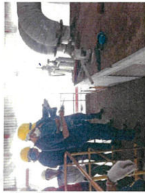
ขั้นตอนที่ 10 ช่างหม้อไอน้ำทำการขันล็อกน็อตยึดตัว Upper Drum ด้านขวา ขั้นตอนที่ 11 ช่างหม้อไอน้ำทำการใส่โอเปกออก โดยการโยกคันโยกประมาณ 2 – 3 ครั้ง ๆ ละ 30 วินาที – 1 นาที จนโอเปกออกหมด
