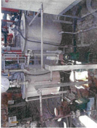
ขั้นตอนที่ 7 สดาร์บีป้อนสารเคมีเข้าหม้อไอน้ำ (High pressure Chemical pump)
